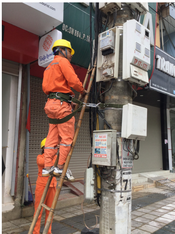
Công nhân Điện lực TP. Điện Biên Phủ tiến hành kiểm tra công tơ điện tử trên địa bàn.
